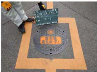
埼玉県・再生水の供給配管上に設置された消火栓
