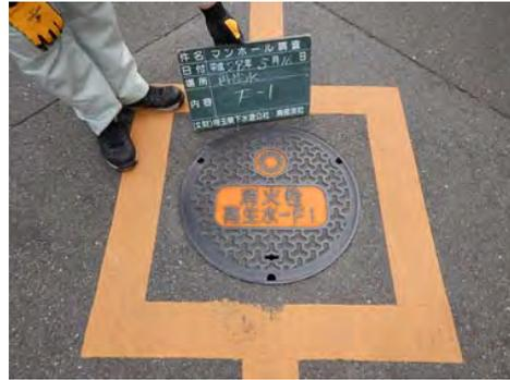
再生水供給配管上に設置された消火栓の例(消防用水)
