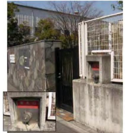
下水再生水を採水口から供給する事例(防火用・雑用水)
