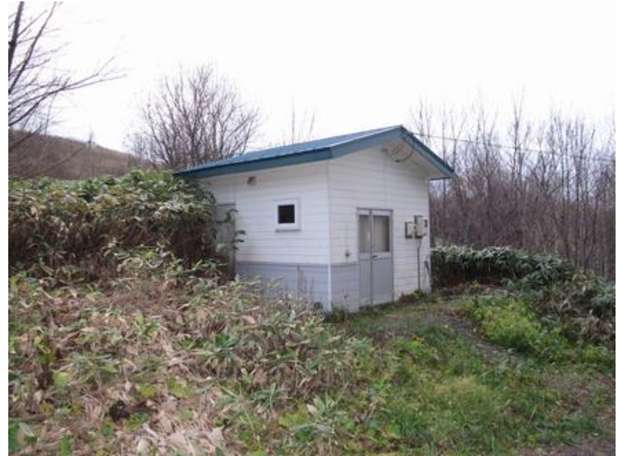
浄水処理施設 急速ろ過＋塩素
