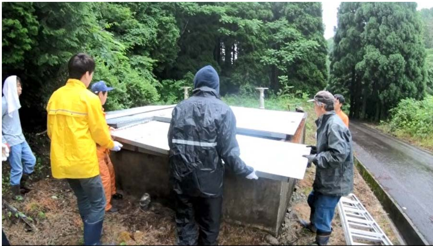
ろ過池の清掃作業（T県N飲供）
