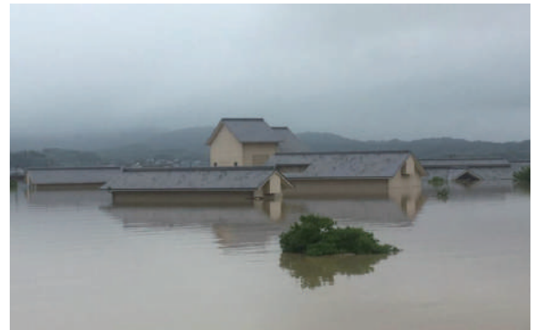
水没した倉敷市真備浄化センター
