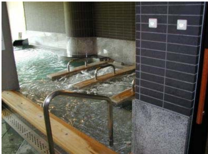
温泉等入浴施設
