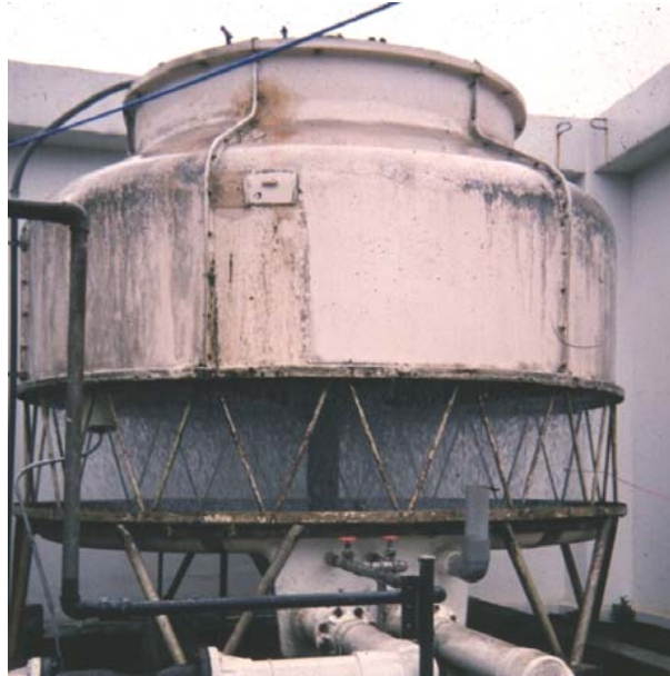
冷却塔（空調施設）
